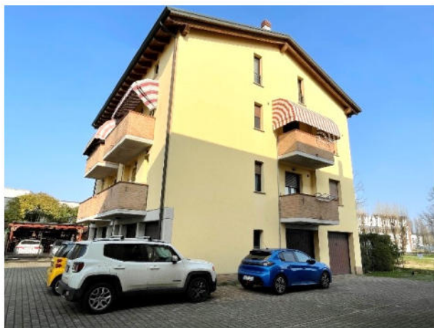
foto n. 1: vista lato Sud-Ovest del fabbricato che ricomprende l'u.i. staggita
