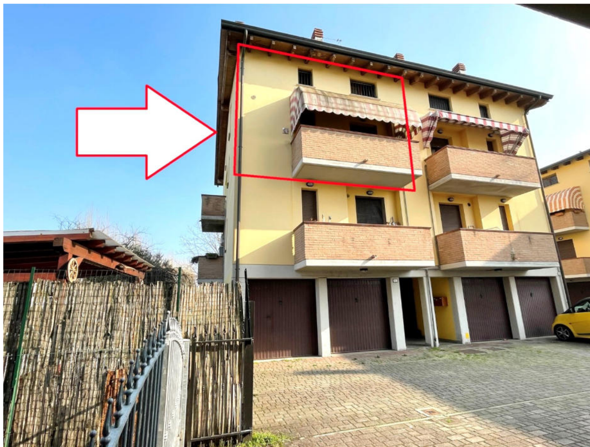
foto n. 3: vista lato Ovest del fabbricato che ricomprende l'u.i. staggita
